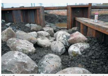
Herstellung differenzierter Strömungsverhältnisse im Fischpass mit Naturbausteinen
