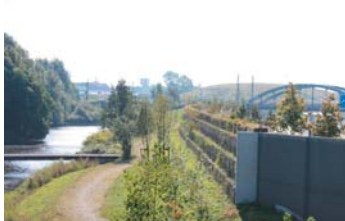
Lärmschutzanlage aus begrünten Gabionen zum Schutz des Hakenburger Sees
