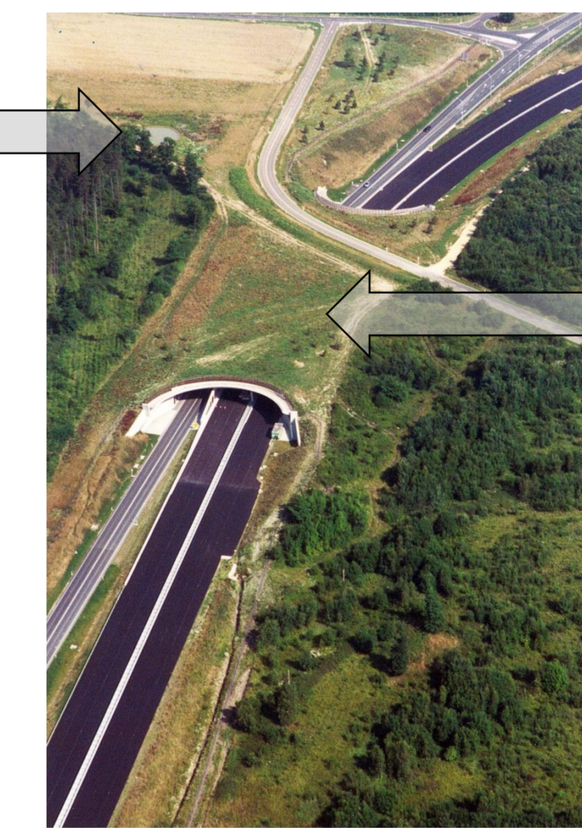
Grünbrücke „Rouscht“ 2001 kurz vor Eröffnung der Straße
