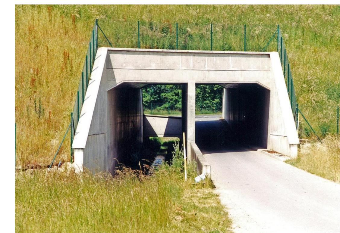
Kombiniertes Bauwerk Wellerbach nach Fertigstellung 1998
