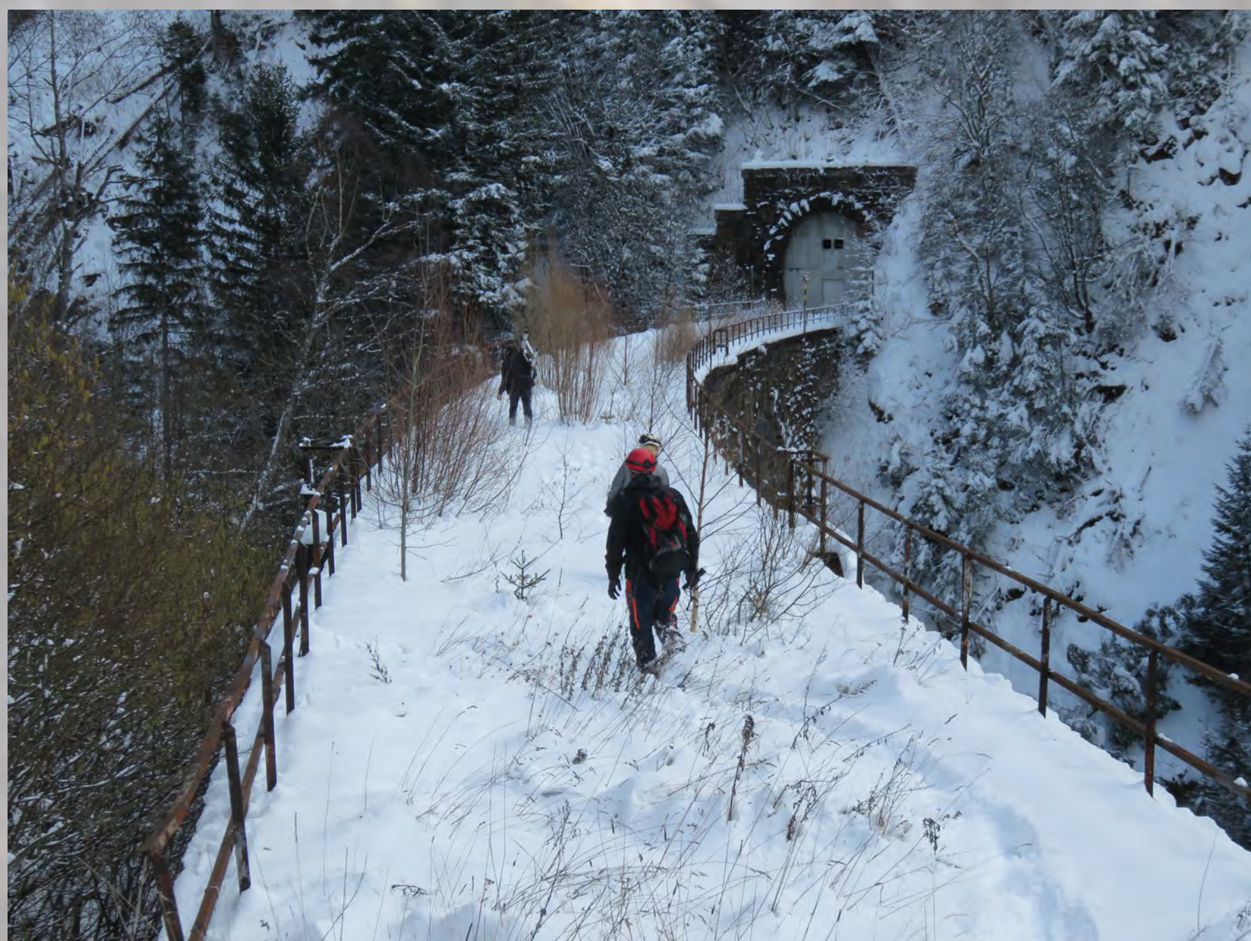
1. Stillgelegter Bahntunnel entlang der Tauernbahnstrecke in Kärnten, Österreich.
