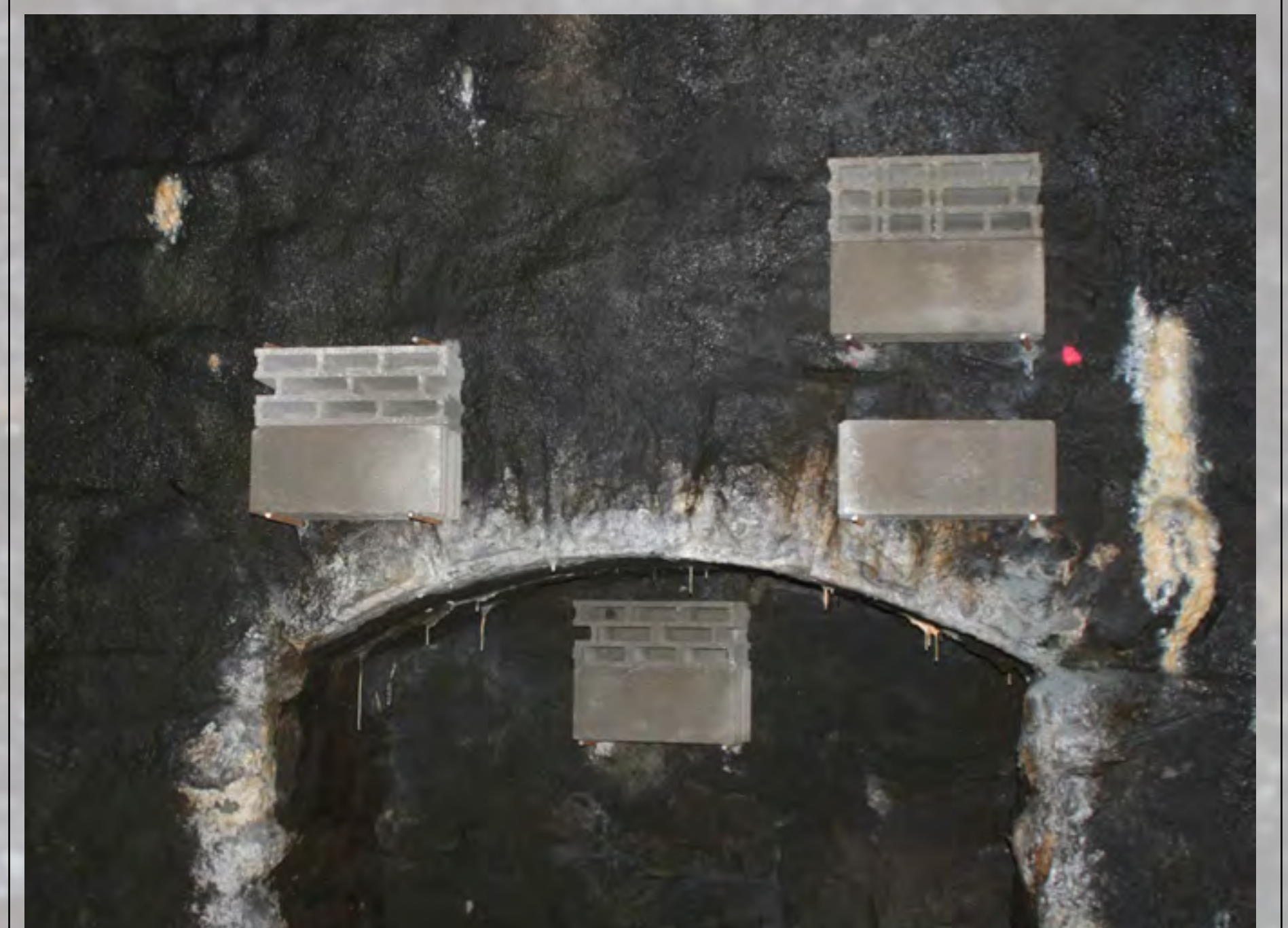
6. Hohlbetonziegel werden an klimatisch günstigen Stellen montiert und sollen für ein größeres Spaltenangebot für Fledermäuse in den Tunnel sorgen.
