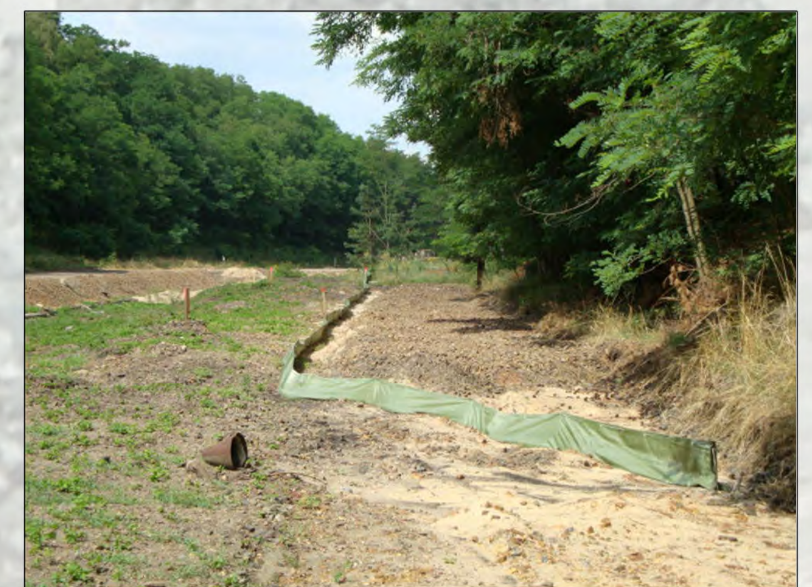
Schlingnatterhabitat 2: Ansicht Süd (Baufeld links im Bild), Stand Juli 2010
