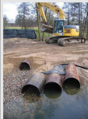
Die Umfahrung wurde auf drei wasserführenden Röhren errichtet, um sowohl den Durchfluss als auch die Passierbarkeit für Gewässerorganismen zu gewährleisten. Zusätzlich wurde eine Trockenröhre für die gefahrlose Querung von Kleintieren vorgesehen. In alle Röhren wurde eine Kiesschüttung eingebracht, die die Barrierewirkung verringert.
