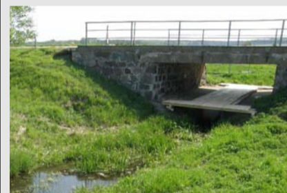
Um das Abbruchmaterial aufzufangen und so eine Beeinträchtigung des aquatischen Lebensraums zu vermeiden, wurde bei der Funderbrücke eine Holzplattform auf den Bermen installiert. Unter die Stremmebrücke wurde eine Schute mit aufmontierter Holzplattform geschoben.
