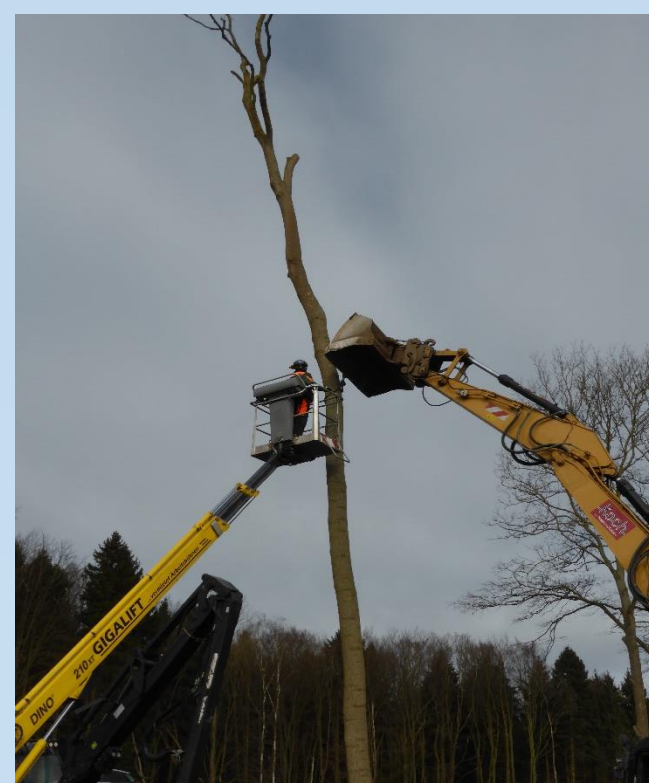
Abb. 8: Stückweise Abtragen eines Baumes und Sicherung eines Fledermausquartiers mittels Kran
