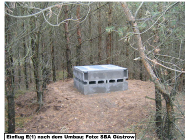
Einflug E(1) nach dem Umbau; Foto: SBA Güstrow
