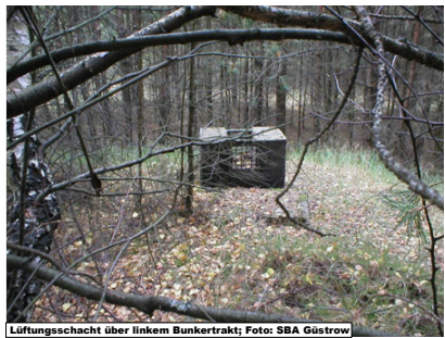
Lüftungsschacht über linkem Bunkertrakt; Foto: SBA Güstrow
