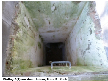
Einflug E(1) vor dem Umbau; Foto: R. Koch
