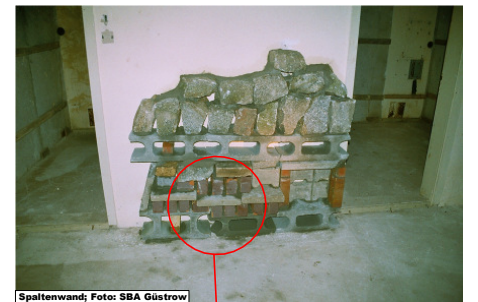
Spaltenwand; Foto: SBA Güstrow
