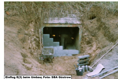
Einflug E(3) beim Umbau; Foto: SBA Güstrow
