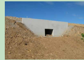
Portalelement eines Durchlasses zwischen BW 12 u. 13 in der Bauphase (K. Brückner)
