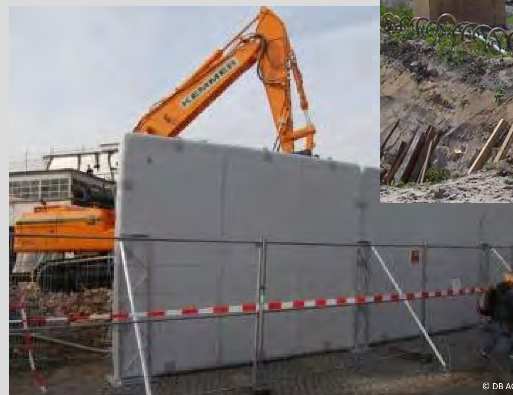
Umbau Bf. Rangsdorf: Pilotierung mobiler aufblasbarer CENO TEC-Schallschutzwände
