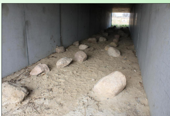
Trockendurchlass mit naturnah gestalteter Sohle mit Markierungssteinen
