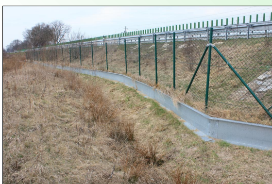
Fischotterschutzzaun in Kombination mit Amphibienleiteinrichtung
