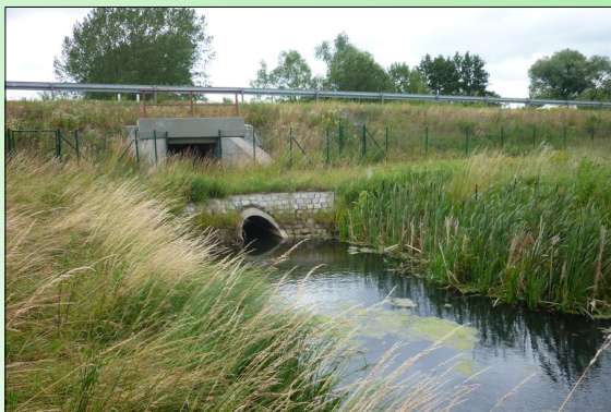
Gewässerdurchlass (Vordergrund) in Kombination mit fischotter- und amphibien-gerechtem Trockendurchlass (Hintergrund)
