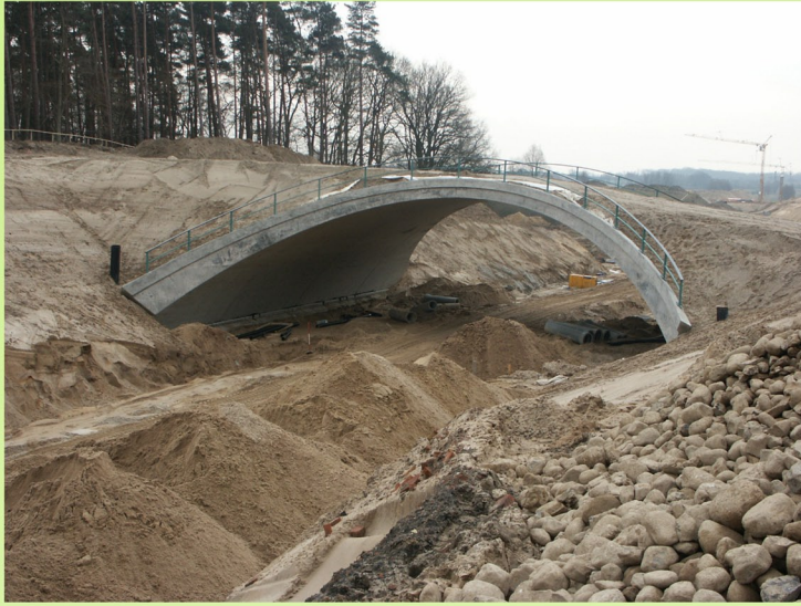
Bau der Brücke im März 2007
