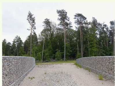
Gabionen säumen die Brücke über die B 207
