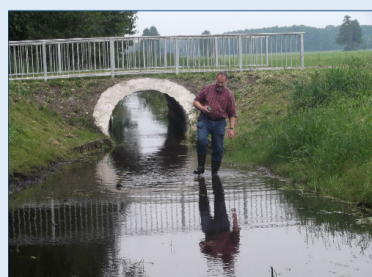
Untersuchung der neuen Gewässersohle durch die UNB und neuer Durchlass
