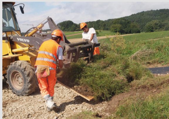
Aufnahme der zwischengelagerten Rasensoden
