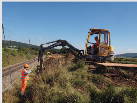
Entnahme der Rasensoden im Sommer 2010
