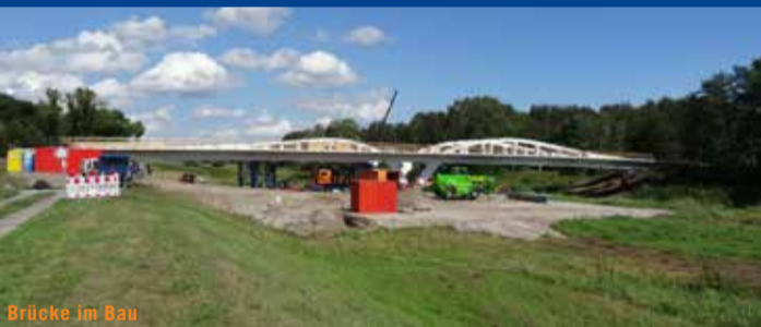
Brücke im Bau
