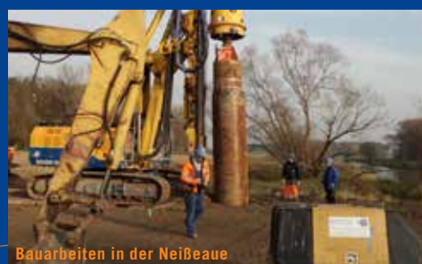
Bauarbeiten in der Neißeau
