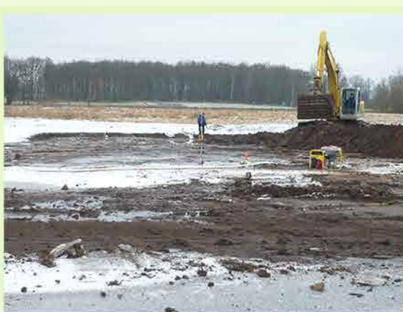
Auch für Kompensationsmaßnahmen (hier die Anlage von Gewässern) sind oftmals umfangreiche Baumaßnahmen erforderlich, die durch die UBB begleitet werden.
