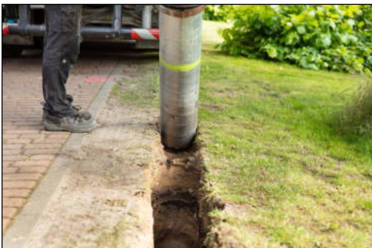
Bei größerer Verdichtung muss das Erdreich zuvor mit einer Sprenglanze gelöst werden. Auch dieses Verfahren ist weitestgehend wurzelschonend. Die Freilegungstiefe kann jedoch auch durch flach verlaufende Wurzeln begrenzt werden. Außerdem wurde in der Praxis festgestellt, dass durch den Dauerbetrieb des LKW unter den Baumkronen und den damit verbundenen Abgasen Verbrennungsschäden an den Blättern eintreten können.
