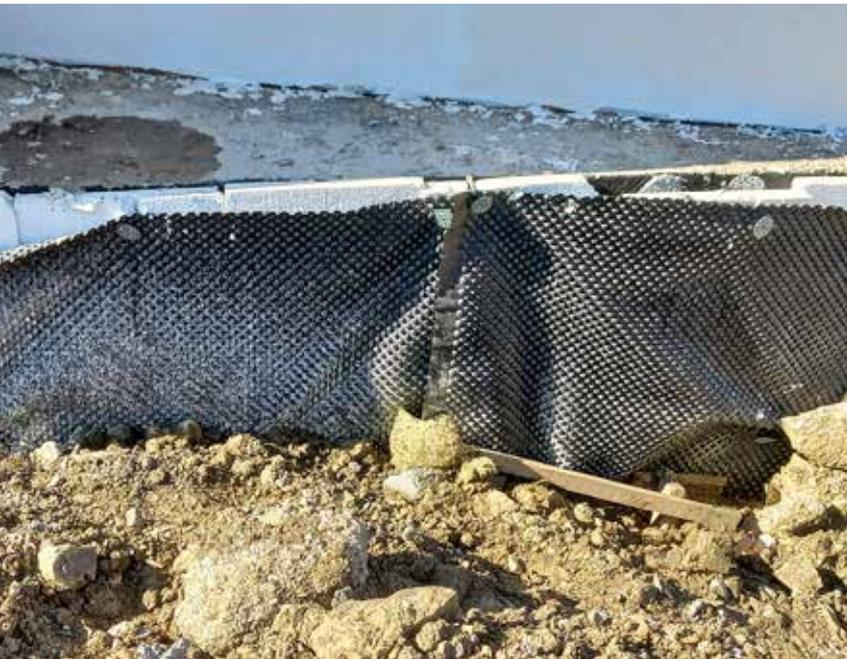
Während des Baus der Infrastruktur werden Geomembranen aufgebracht, um die Wasserbeständigkeit zu erhöhen. Foto: Pamirc
