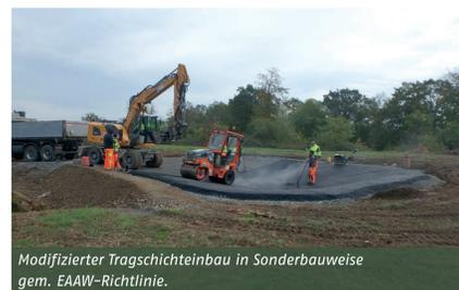
Modifizierter Tragschichtenaufbau in Sonderbauweise gem. EAAW-Richtlinie.
