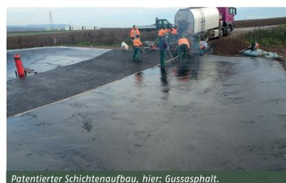
Patentierter Schichtenaufbau, hier: Gussasphalt.
