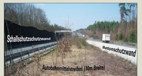
Abb. 6: Beprobter Autobahnmittelstreifen mit Parallelbauwerken.
