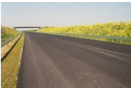
Begleit“gelb“ schon in der Bauphase
