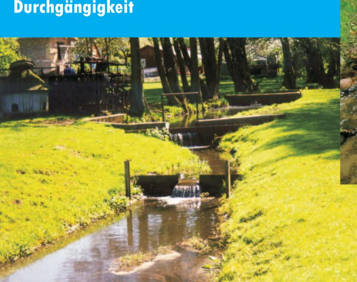
Nachher: Umbau in naturnahe Sohlgleite mit ca. 1,8% Gefälle und einzelnen Becken auf 80 m Länge
