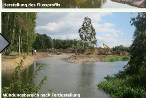
Die Gesamtlänge der Schleife beträgt ca. 500m. Der bisherige Flusslauf wird durch einen Überlaufdamm abgetrennt, steht aber im Hochwasserfall als Abflussweg zur Verfügung.
