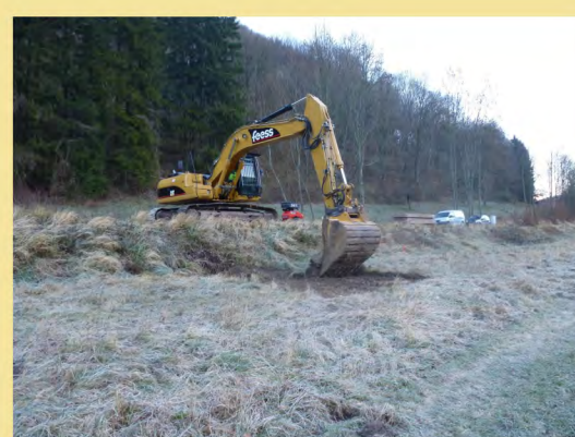
Abb. 7 und 8: Bodenabtrag vor Kopf von befestigten Flächen aus bzw. auf Baggermatratzen
