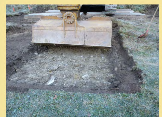
Abb. 7 und 8: Bodenabtrag vor Kopf von befestigten Flächen aus bzw. auf Baggermatratzen
