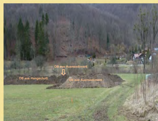
Abb. 5 und 6: Oberboden- und Unterbodenmieten getrennt nach Bodentypen
