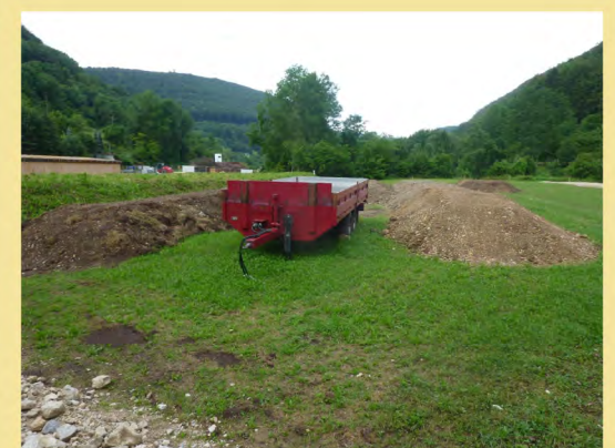
Abb. 5 und 6: Oberboden- und Unterbodenmieten getrennt nach Bodentypen
