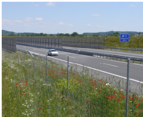
BAB A38 (VKE 5614) westlich Niedergebra mit beidseitigem Fledermausschutzzaun und einem Zaun im Mittelstreifen
